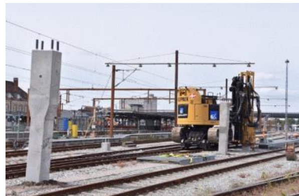
Nedramning af mastefundamenter på Næ station onsdag 27. maj 2020 .
