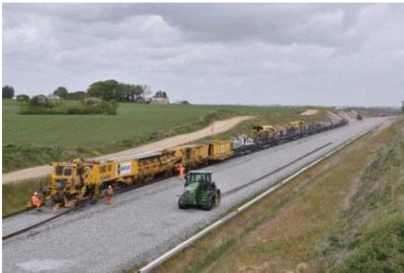
Sporbyggeren, der kun blev anvendt på Møllebakken . Kan lægge 240 m spor i timen. Foto lørdag 23. maj 2020 .
