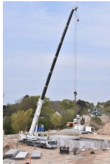
Ved Ganges Bro er den gamle vejbro væk og erstattet af en faunapassage mandag 27. april 2020.
