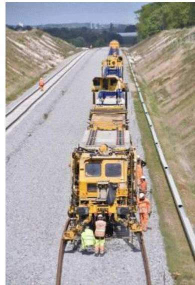
Sporbyggeren arbejdede i det andet spor mandag 25. maj 2020 . Det midtliggende overhalingsspor er lagt manuelt.
