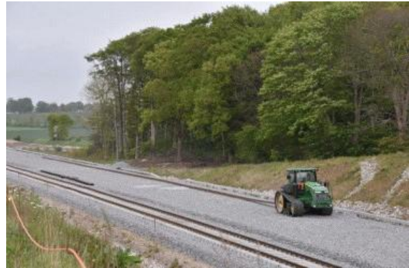
En stor traktor med larvefødder trækker skinner ud på Møllebakken (kommende) station lørdag 23. maj 2020.
