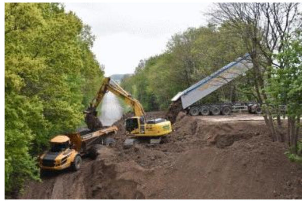
Overskudsjorden er primært hældt i de dybe gennemskæringer nord for Gz . Foto ved Åsø mandag 18. maj 2020.
